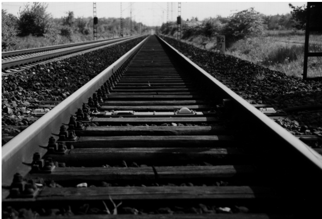
Slika 14: Vgradnja kontrolnega praga za podvozje (KPP) v tir
